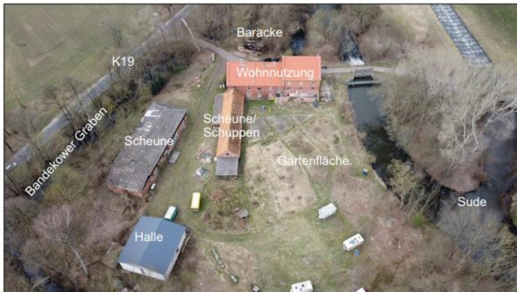
Abbildung 3: Drohnenaufnahme von März 2022, saniertes Dach des Hauptgebäudes
