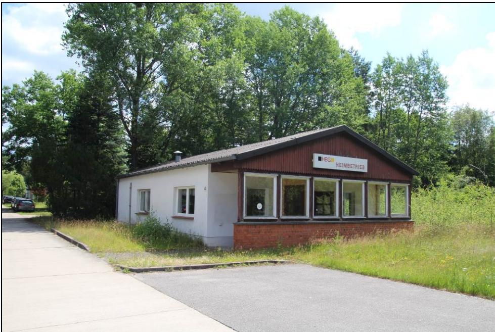
Abbildung 4: Ansicht des ehemaligen MHO, zwischenzeitlich als Moschee genutzt
