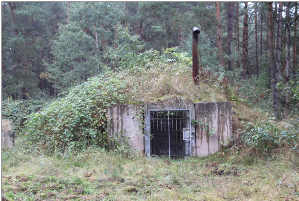
Abbildung 13: oberirdischer Bunker, der als Fledermausquartier ausgebaut werden sollte
