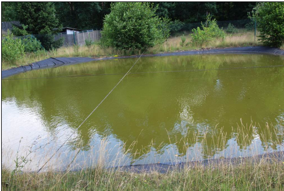
Abbildung 19: Löschwasserbecken im Untersuchungsgebiet
