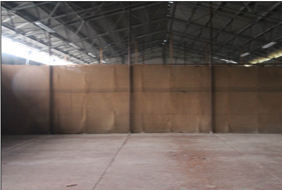
Abbildung 6: Innenansicht der ehemaligen Fahrzeughalle
