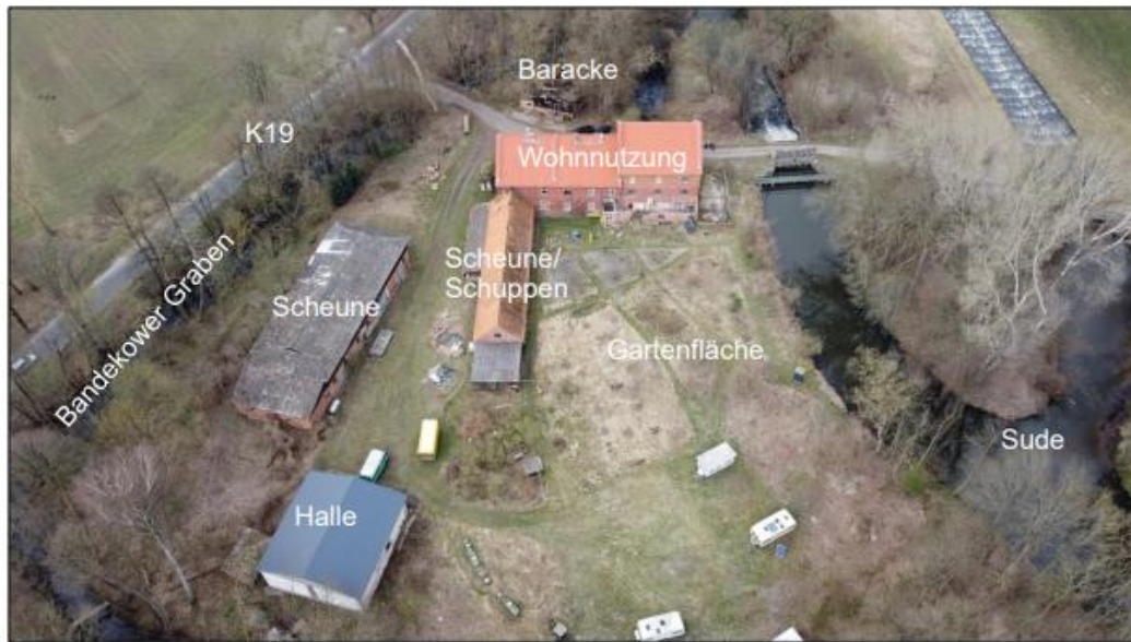
Abbildung 1: Drohnenaufnahme von März 2022, saniertes Dach des Hauptgebäudes
